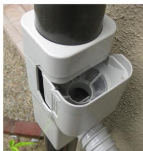
雨水タンク（上部流入方式(オーバフロー)方式）
