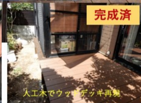
腐蝕部分を削り、添木してコーティング
