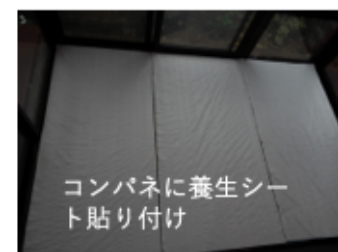
コンパネの上にビニール床シートを貼り付け
