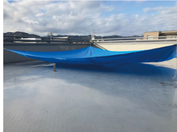
設置完了 (約 15 分)
