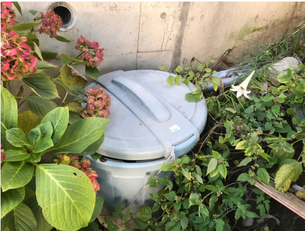
〈雨水タンクへの水路作成作業風景〉
